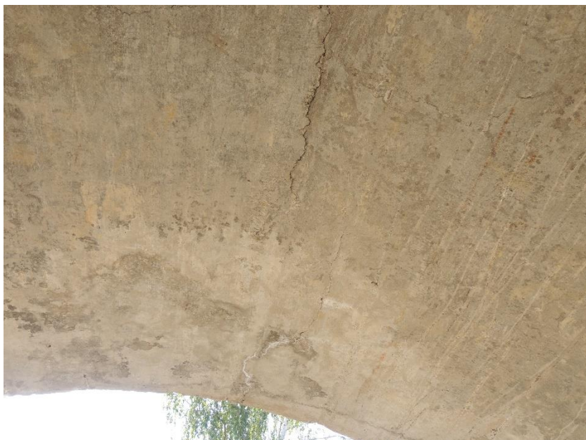
Pohled na trhlinu ve vrcholu klenby K01
