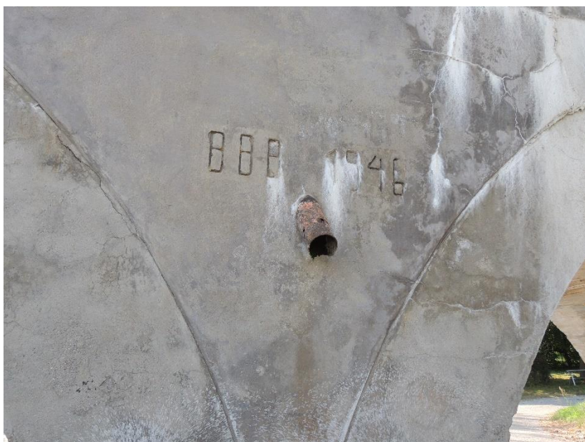
Pohled na letopočet postavení mostu a trubku odvodnění rubu kleneb K01 a K02
