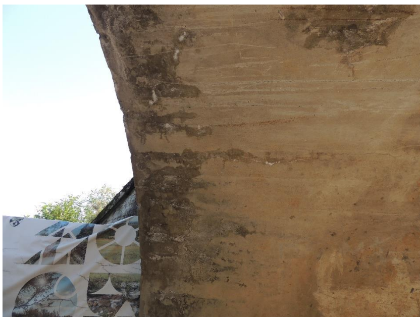
Pohled na stopy po zatékání na hraně klenby K01
