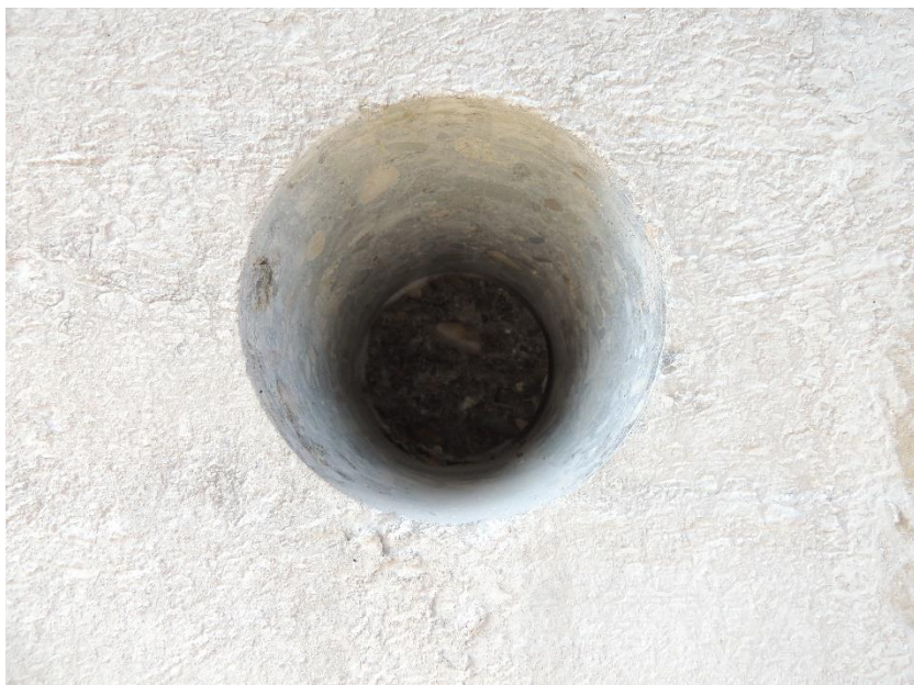
Pohled do otvoru po odběru vzorku betonu z pilíře P01
