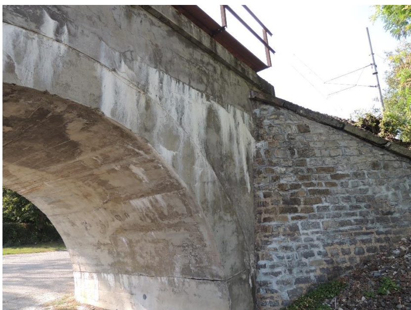
Pohled na poruchy ve formě trhlin ve zdivu nad klenbou K02
