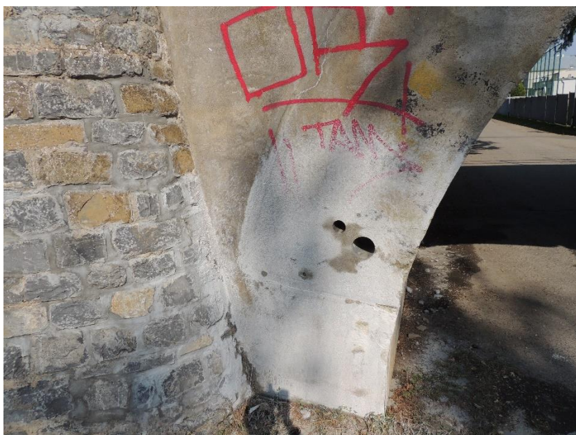
Pohled na místo odběru vzorku betonu z klenby mostu K02 u O02 a místo provedení vrtu přes trhlinu v klenbě K02
