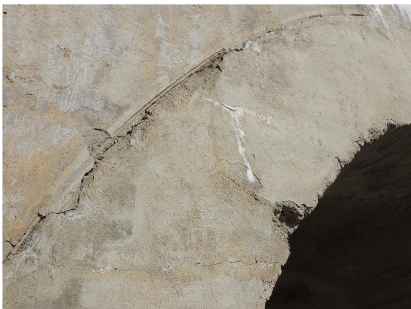
Detail trhliny kopírující průběh horního líce klenby K01
