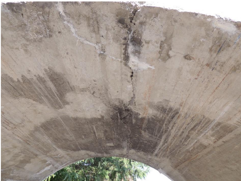
Pohled na trhlinu ve vrcholu klenby K02
