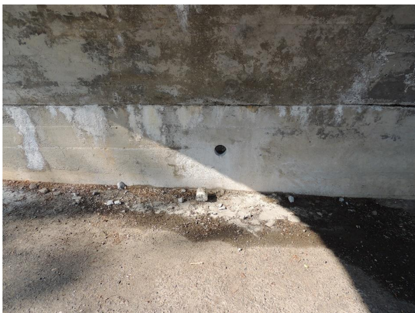
Pohled na místo odběru vzorku betonu z opěry O02
