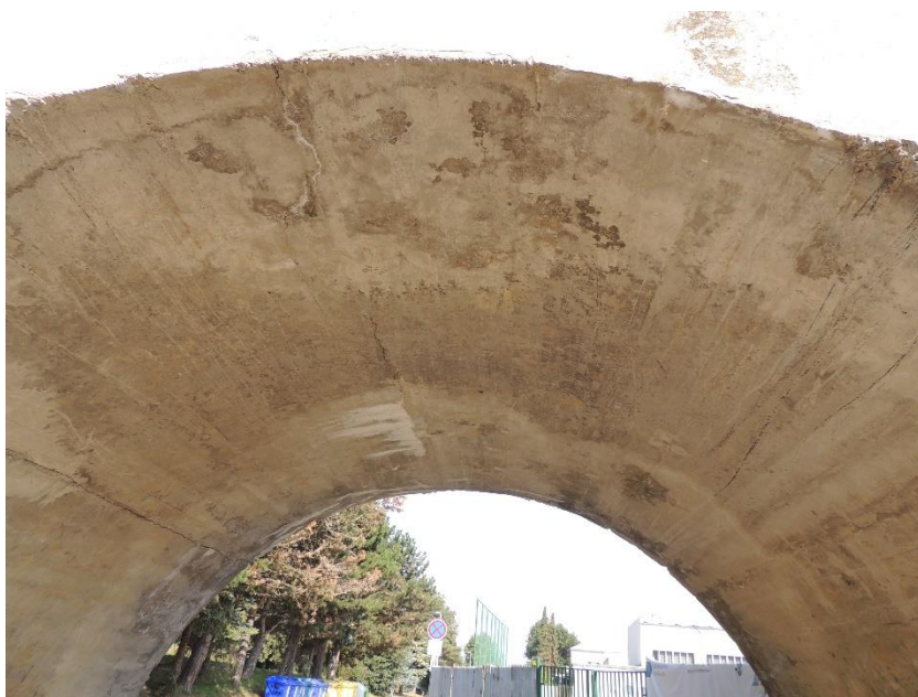
Pohled na spodní líc klenby K01 s poruchami ve formě trhlin
