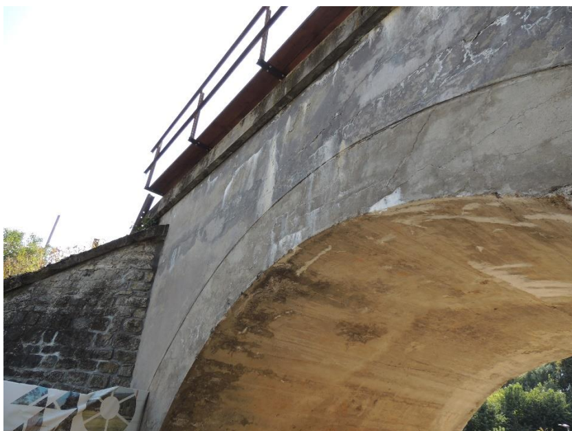
Pohled na poruchy ve formě trhlin ve zdivu nad klenbou K01
