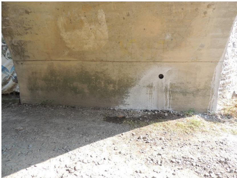
Pohled na místo odběru vzorku betonu z opěry O01
