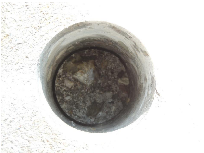
Pohled do otvoru po odběru vzorku betonu z klenby mostu K02
