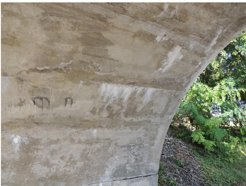
Pohled na další trhliny v klenbě K02
