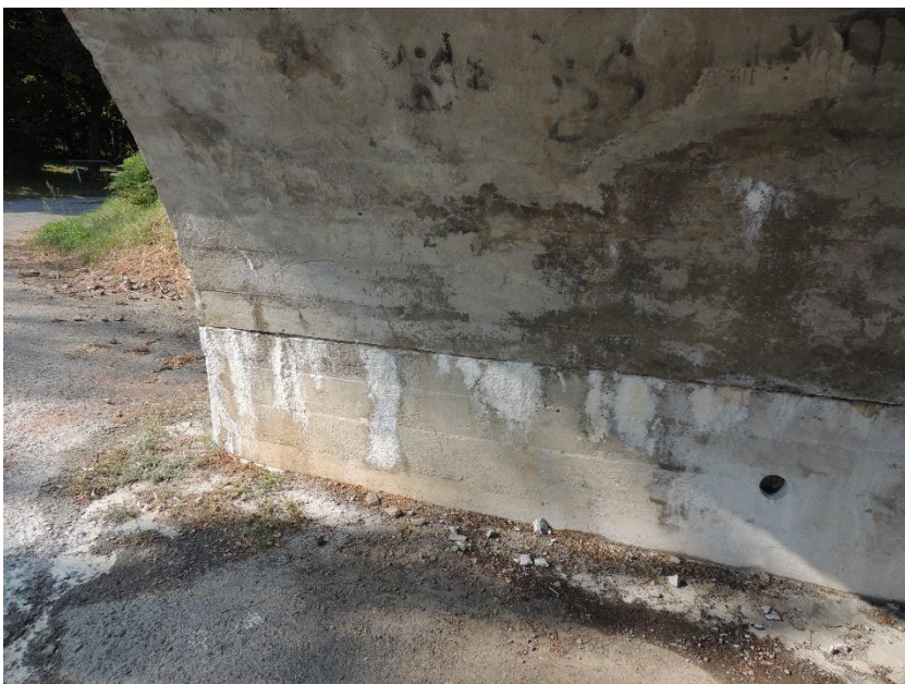
Pohled na vápenné inkrustace na povrchu betonu opěry O02
