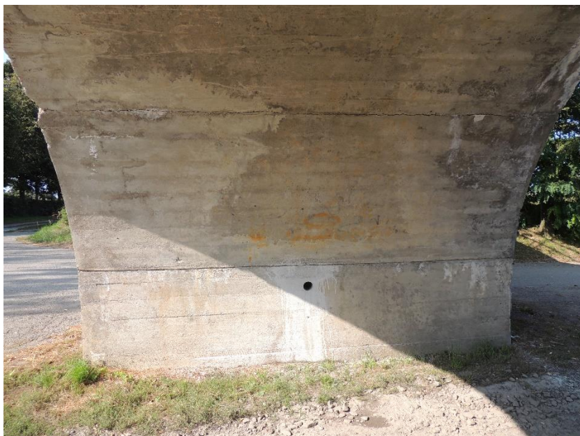
Pohled na místo odběru vzorku betonu z pilíře P01
