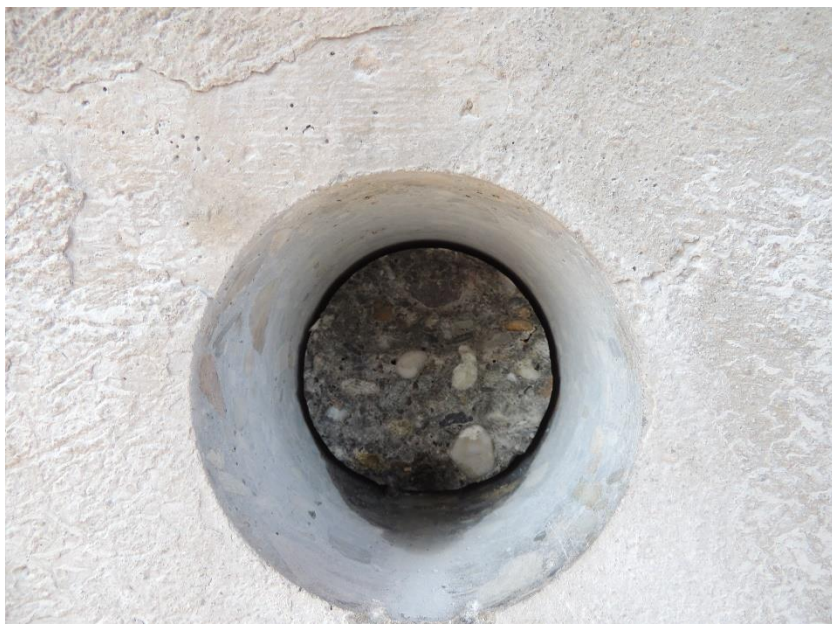
Pohled do otvoru po odběru vzorku betonu z opěry O02
